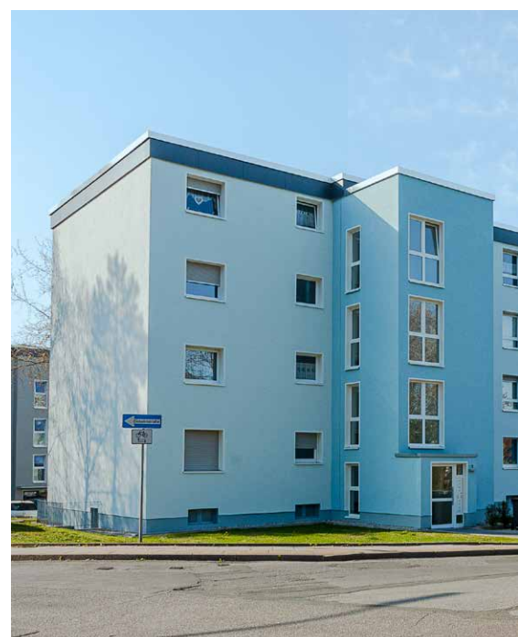
Anbau von Aufzugsanlagen
