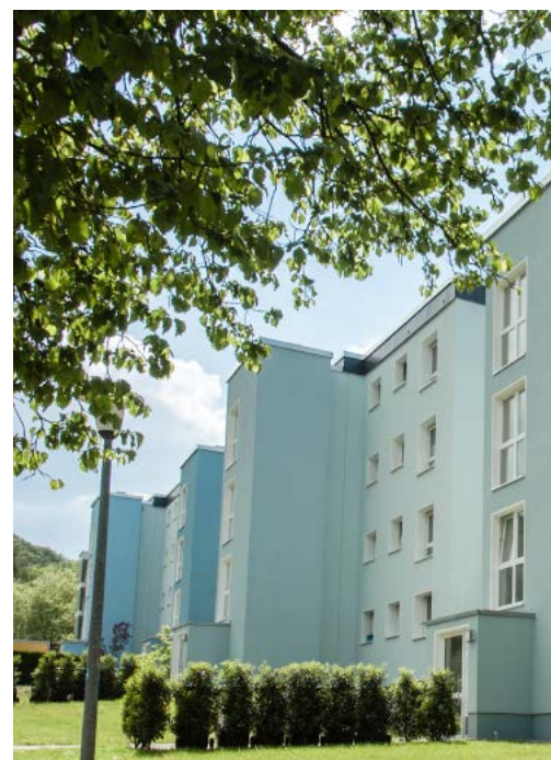
Anbau von Aufzugsanlagen
